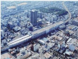
阪神多摩川駅付近（兵庫県芦屋市）
