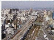
豊島跨線橋とJR北陸線の交差部の状況(平成17年2月)
