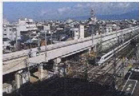
仮日之出踏切とJR北陸線の交差部の状況(平成16年7月)
