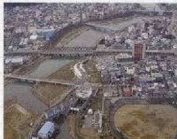
足羽川に架けた仮四車線の状況(平成17年3月)
