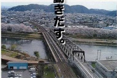
足羽川JR橋梁(平成16年4月撮影)
