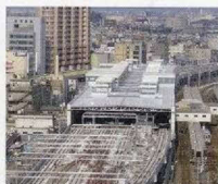
新福井駅舎の状況(平成17年3月撮影)
