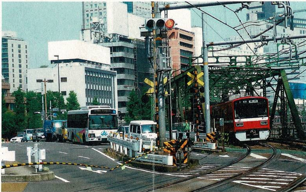
踏切の状況 (補助第149号線・品川第一踏切道)
