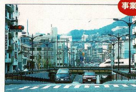
【稲佐橋立体交差の現在の状況】
