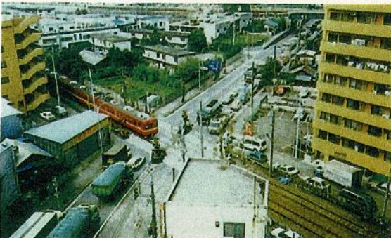
② 都市計画道路国道409号線 京急川崎(大)第2踏切
